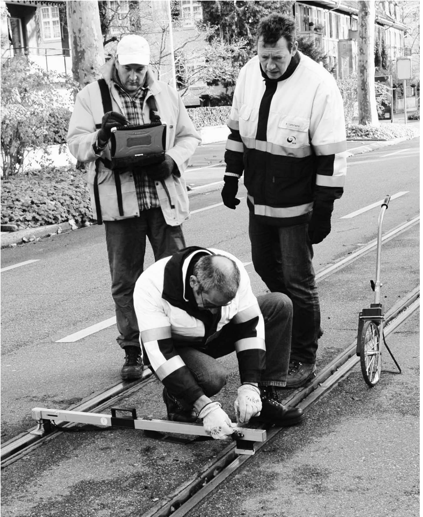
Derzeit werden sämtliche Gleise, Weichen und Kreuzungen der BVB gemessen und visuell beurteilt. Im Bild die Gleisinspektoren Robert Bürgin (vorne) und Beat Lehmann (hinten rechts) mit Günter Dimmer von der Firma Schreck-Mieves, Herstellerin der Software MR.pro®. Foto: Peter Binetti
