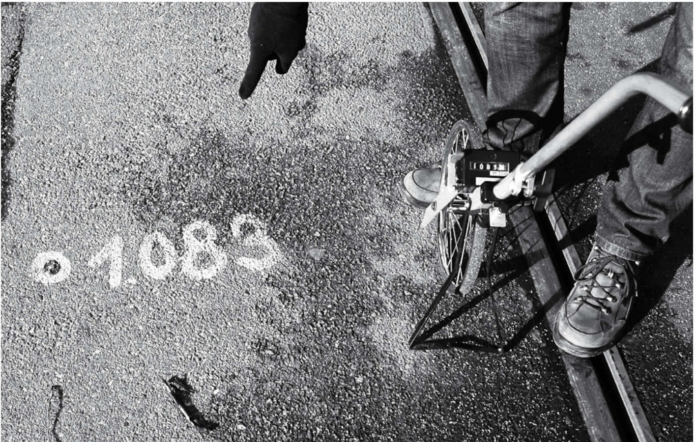
Die Kilometrierung – also ein Bezugspunkt etwa alle 100 Meter – dient sowohl den Inspektoren als auch später den Instandhaltungsteams für die Lokalisierung der Mängel. Foto: Peter Binetti
